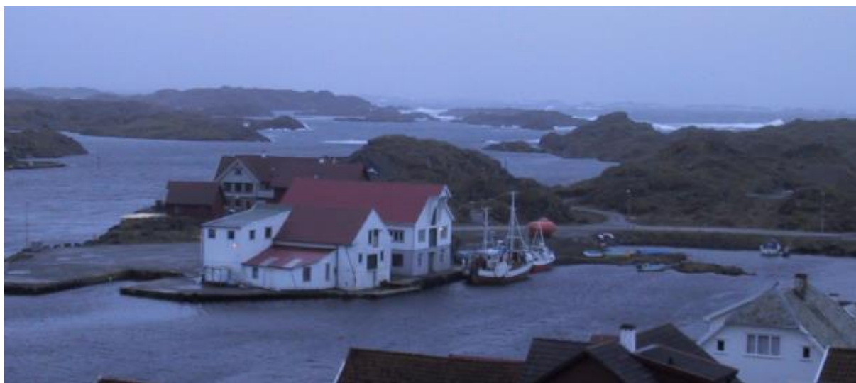
Figur 7. Planområdet sett fra nord med eksisterende bebyggelse.
