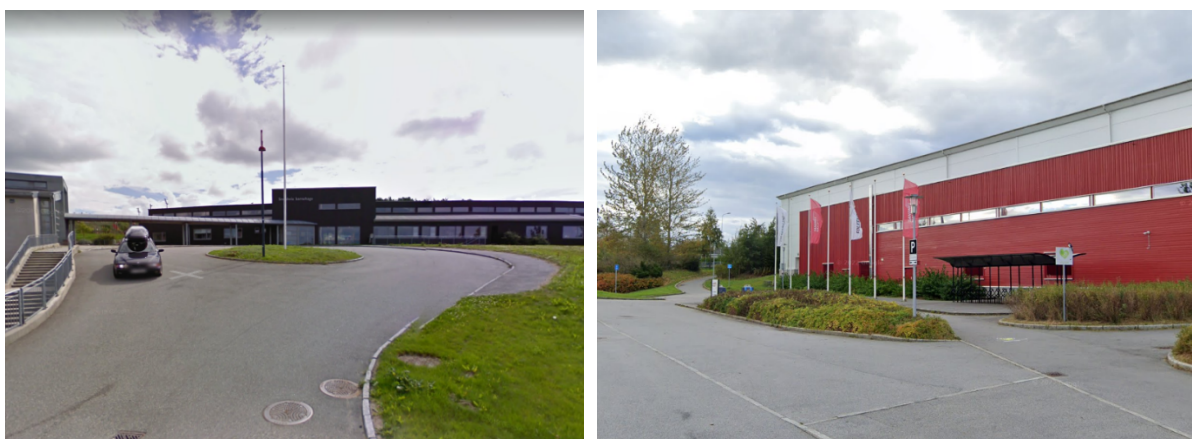
Figur V-2: Utforming av droppsoner ved Smeaheia skole (venstre) og Sandved skole (høyre) i Sandnes kommune. Kilde: Google Maps.
