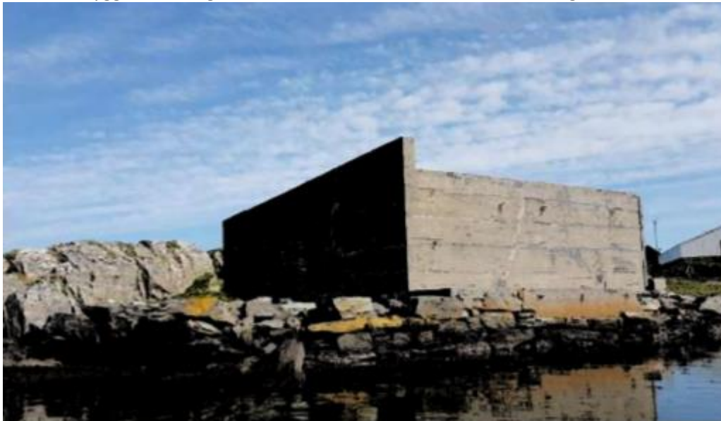
Figur 4: Restene av det gamle sildesalteriet. Foto: Forslagsstiller Aarrestad og Gulliksen.
