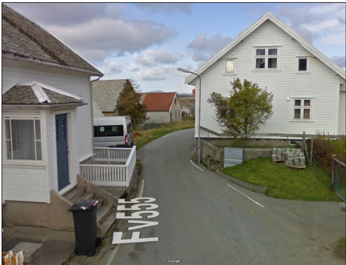
Figur 5: Eksempel på dårlig sikt med boliger tett inntil veggen langs Fv. 4692 (tidl. Fv. 555). Utklipp fra Google Street View, oktober 2010.
