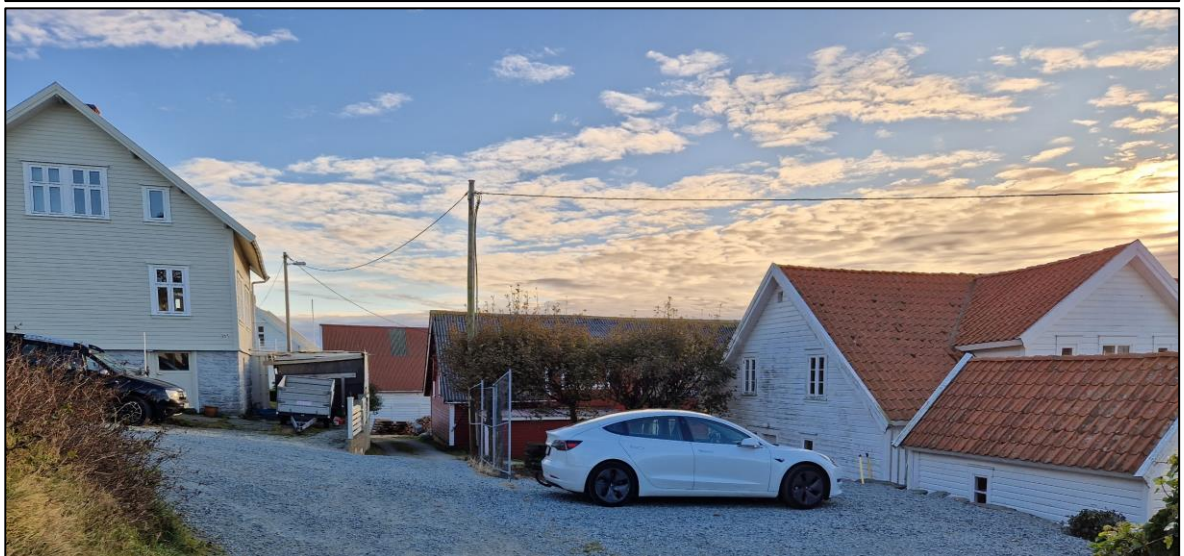
Figur 3: Eksisterende vei har en smal veibredde og smale skuldre og vegggrøfter (over, midt). I enden av vegen i Leiasundet (under) er det kun anlagt gangveg til de innerste boligene, er det vanskelig med tilkomst for utrykningskjøretøy og renovasjon. Foto: COWI, 2023.
