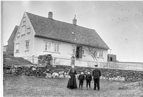
Figur 3. Eksempel på byggestil til bolighus, med empirevinduer, takpanner og uten takutstikk i gavlen. (Ukjent årstall). Kilde: DIVE/Historielaget på Kvitsøy.
