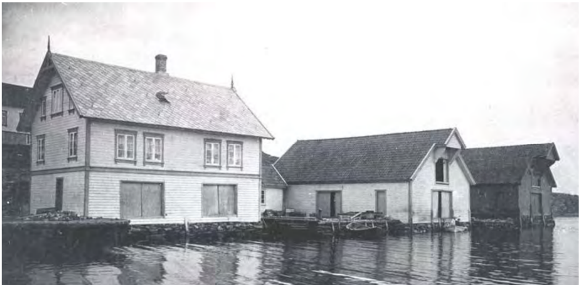
Figur 2. Leiasundveien 173, med originalvinduene i Empirestil og ornamentikk i mønet. Kombinert bolig og sjøhus. I sjøhuset til høyre ser man et eksempel på porter i langsiden hvor varer ble lastet inn. Kilde: Kvitsøy historielag
