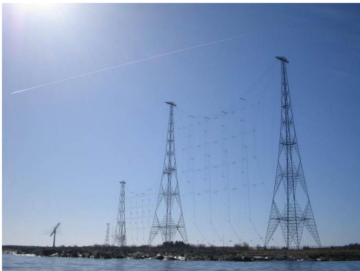
Norkring sine master på Kråkøy. Foto: Kvitsøy kommune.
