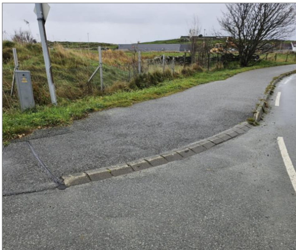
Figur 7. Ved innkjørsel til Ydstebøveien 91., tatt 22.10.2025 av Tormod Høie Meling. Her ser man et eksempel på en fortauskant det er litt ubehagelig å sykle eller trille en vogn over.
