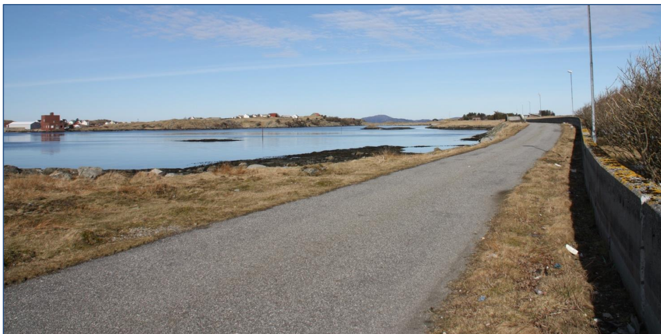
(Asfaltert vei Krågøy-Hestholmen)
